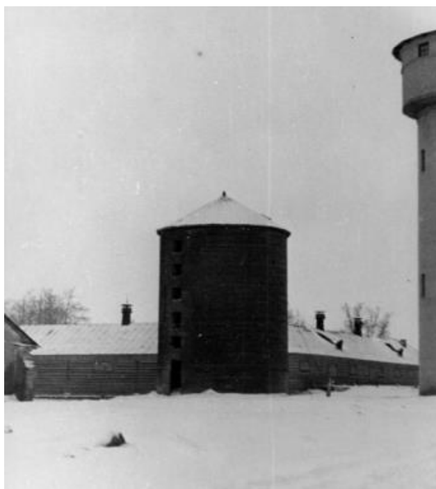
рис. 9. Силосная башня висконсинского типа
